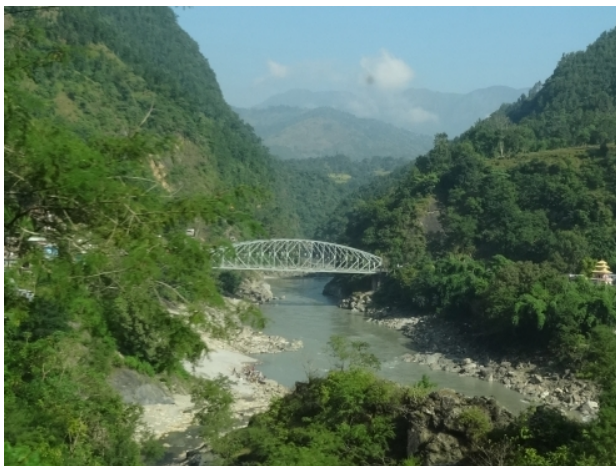
▲アーチ式のトラス橋
