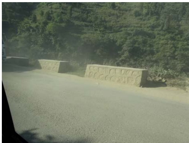
▲山間部における防護柵の状況
