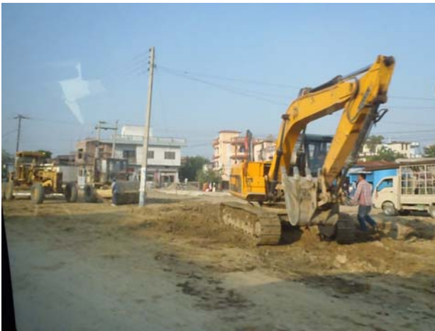
▲道路工事の状況
