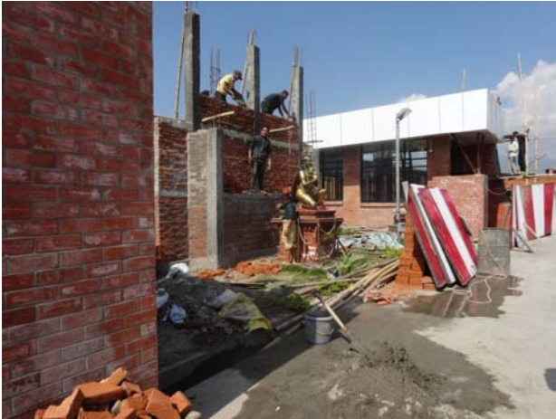
▲モニュメント施工風景
