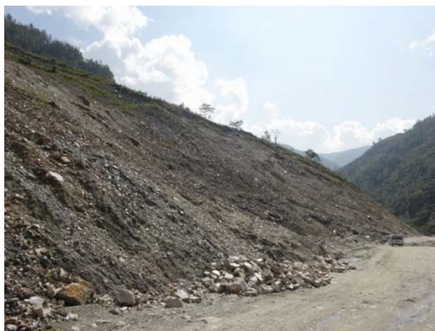
▲地すべり斜面の全景
