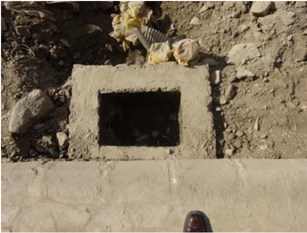
▲路肩部の状況
