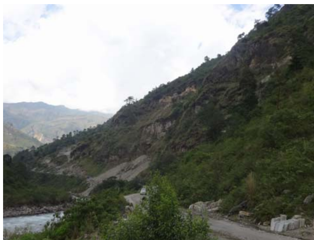
▲地すべり斜面の全景
