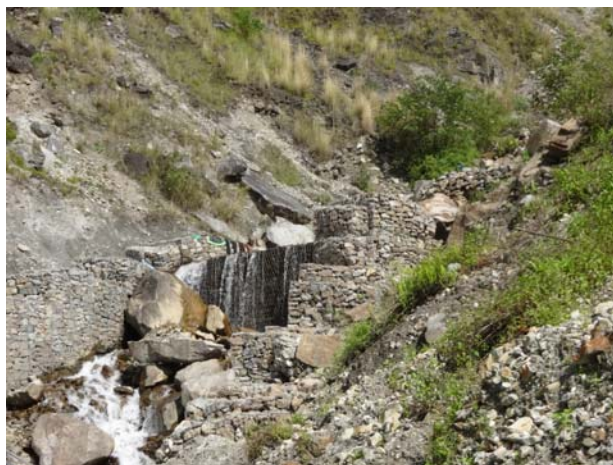
▲階段状に施工された蛇籠
